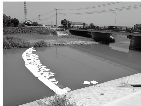
▲油の回収現場
