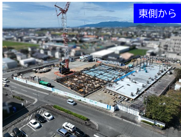
スラブコンクリート打設完了
