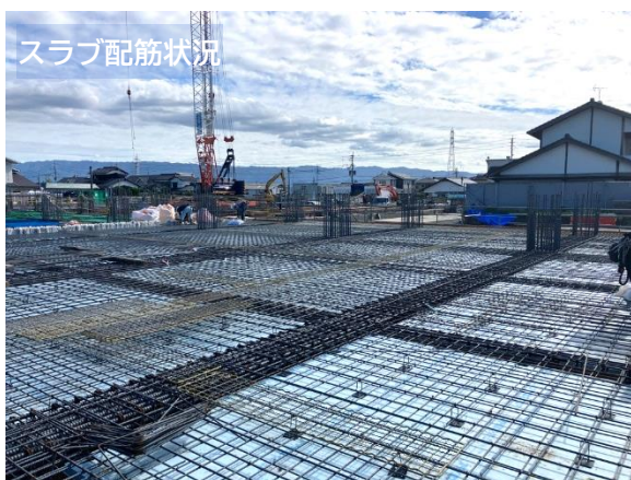
地組梁筋設置状況
