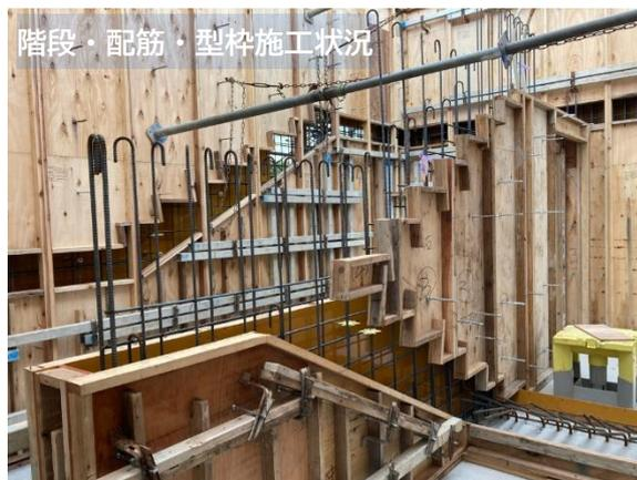
1階の立ち上げ工事が完了し、2階床部分や一部では2階柱・壁の立ち上げ工事が進んでいます。並行して階段の配筋・型枠工事など、躯体内部の工事も進み、徐々に建物の形が見えてきました。今後2階の立ち上げ工事が進むと、12月には3階部分が徐々に立ち上がっていく予定です。
