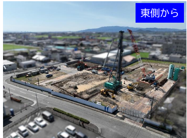
杭打機とクローラークレーン
