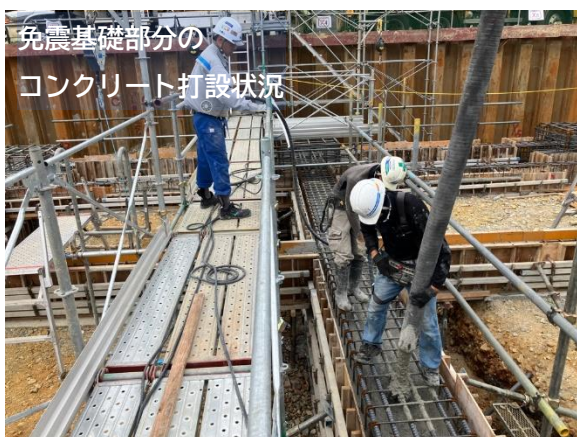
コンクリート打設状況
