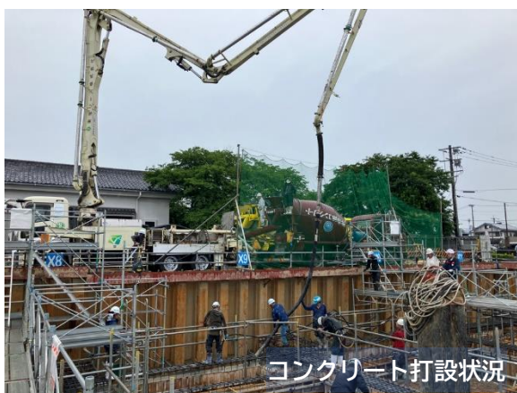
免震基礎部分の コンクリート打設状況
