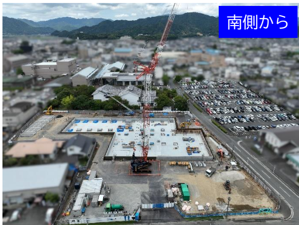
免震下部基礎土間コンクリート打設完了
