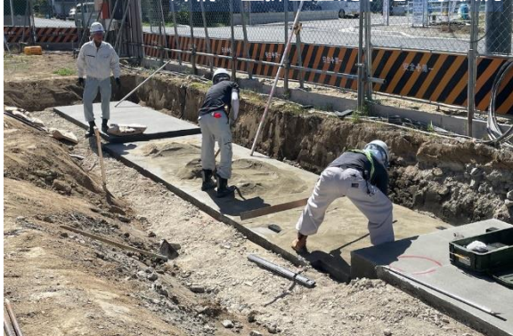
外構L型擁壁基礎下地工事状況
