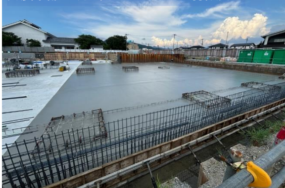
免震下部基礎土間コンクリート打設完了
