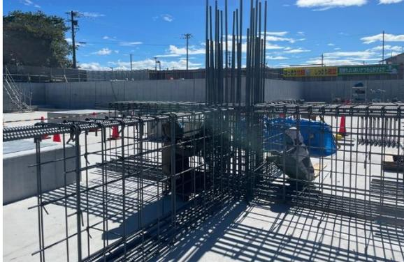
免震上部基礎配筋型枠状況
