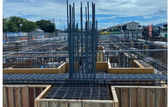
免震装置・免震上部基礎PCa(\*)据付状況
