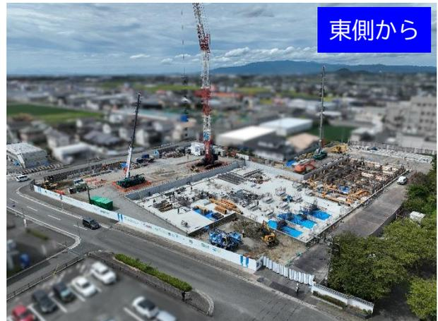
免震上部基礎鉄筋地組状況
