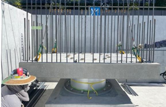
免震下部基礎部分の工事が完了し、免震装置の据え付けが始まりました。新庁舎全体で51か所に免震装置を配置し、地震対策を施します。免震装置の据え付けが終わった工区から順に免震上部基礎工事を進め、その後1階の躯体工事へと進んでいきます。
