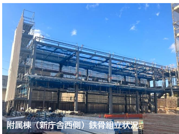
4階柱・梁部分の組立状況
