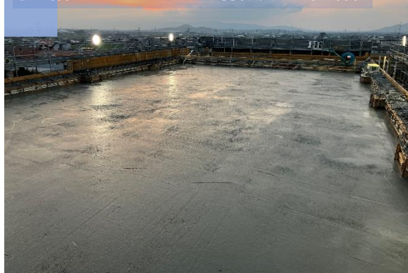
最上階へのコンクリート打設完了（上棟）
