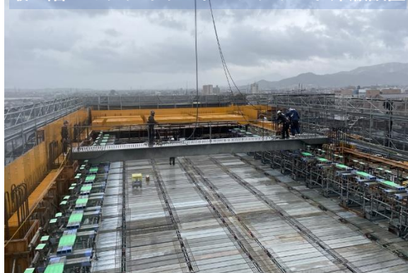
最上階へのコンクリート打設完了（上棟）
