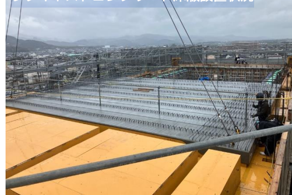
プレキャストコンクリート床版設置状況
