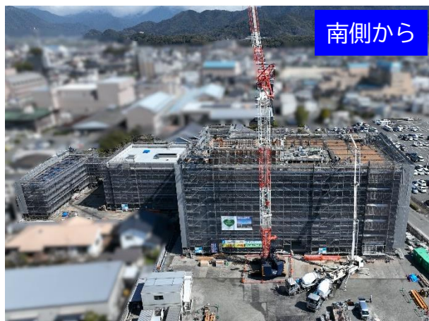
最上階へのプレキャストコンクリート床版設置
