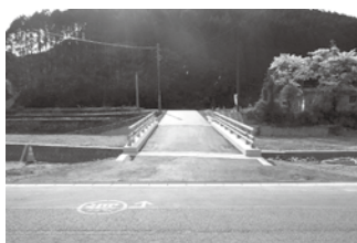
復旧した向橋（黒川）
