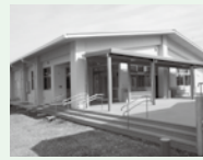
久喜宮地域 防災拠点施設
