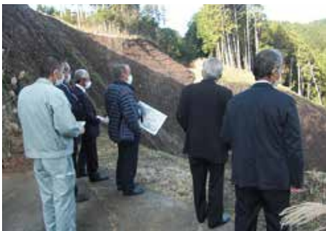
大規模な崖崩れ発生箇所 道路が寸断されている
