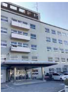
令和7年度移転予定の現庁舎
