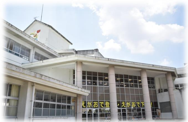
増築・改修予定の立石小学校
