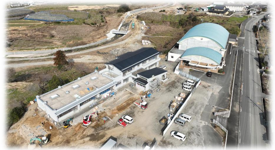
整備中の防災拠点施設(志波小学校跡地)
