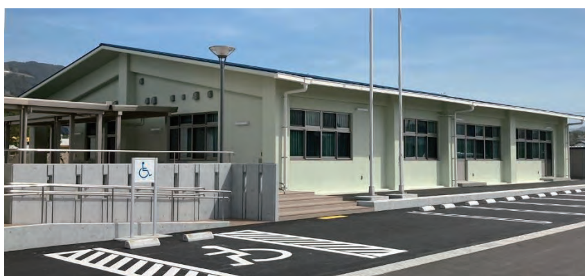
久喜宮地域防災拠点施設
