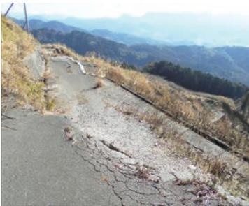
がけ崖崩れで寸断された道路
