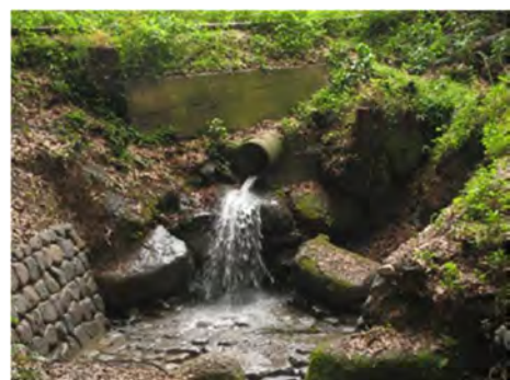
図1-28 杷木神籠石第2水門
