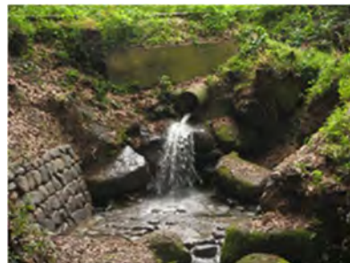
図3-15 杷木神籠石第2水門
