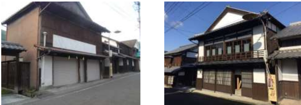
図5-5 建物修理・修景の前（左）と後（右）
