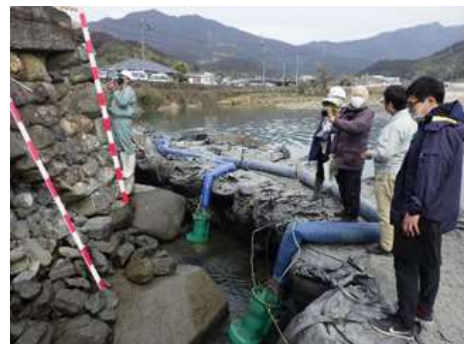
図5-3 女男石護岸施設の災害復旧事業
