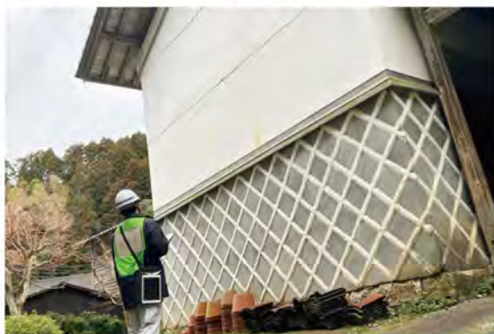
タブレットを活用した現地調査（能登半島地震被災地）
