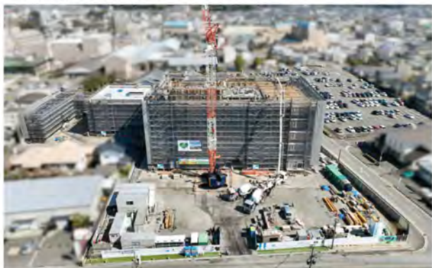
優先すべきを見極め 活力ある朝倉市へ（建設中の新庁舎）
