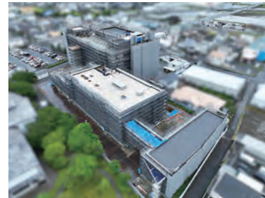
建設中の新庁舎 （北西側より撮影）
