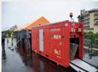
▲浸水対策として原鶴調整池に新たに導入された排水ポンプ
