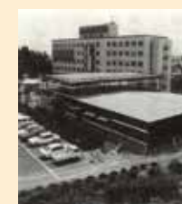
▲建設中の別館
